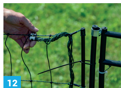
12 Připevněte svorku pro připojení sítě mimo průchozí prostor Attach the net connection clamp outside the passage area
