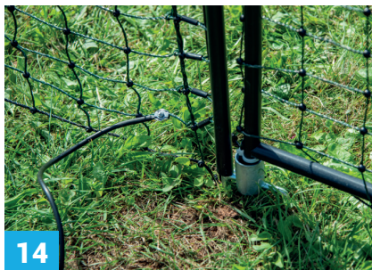
14 Připojení podzemního kabelu k sítím vlevo a vpravo od branky Connecting the underground cable to the nets on the left and right of the gate
