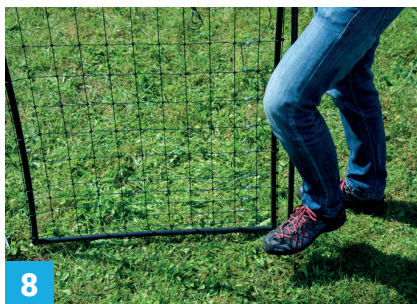
8 Zatlačení sloupku branky do země, kolem které se branka otáčí Pushing the gate post into the ground around which the gate pivots
